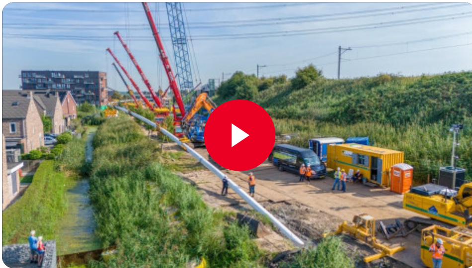
project "Boring onder de Merwede"
